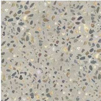
Полированный на крупном заполнителе на сером бетоне
